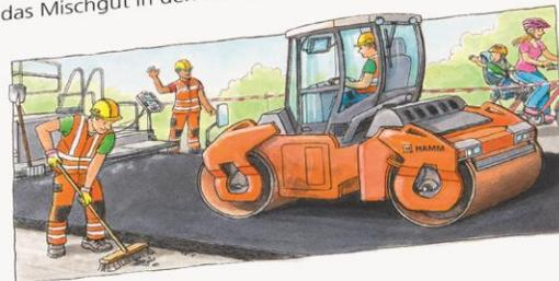
Direkt hinter dem Asphaltfertiger fahren schwere Walzen über die Fahrbahn, um den frischen Belag fest und glatt zu machen. Die Vibrationswalze arbeitet zusätzlich zum Gewicht der beiden Walzen noch mit Schwingungen, die in die Tiefe gehen und für mehr Haltbarkeit sorgen.
